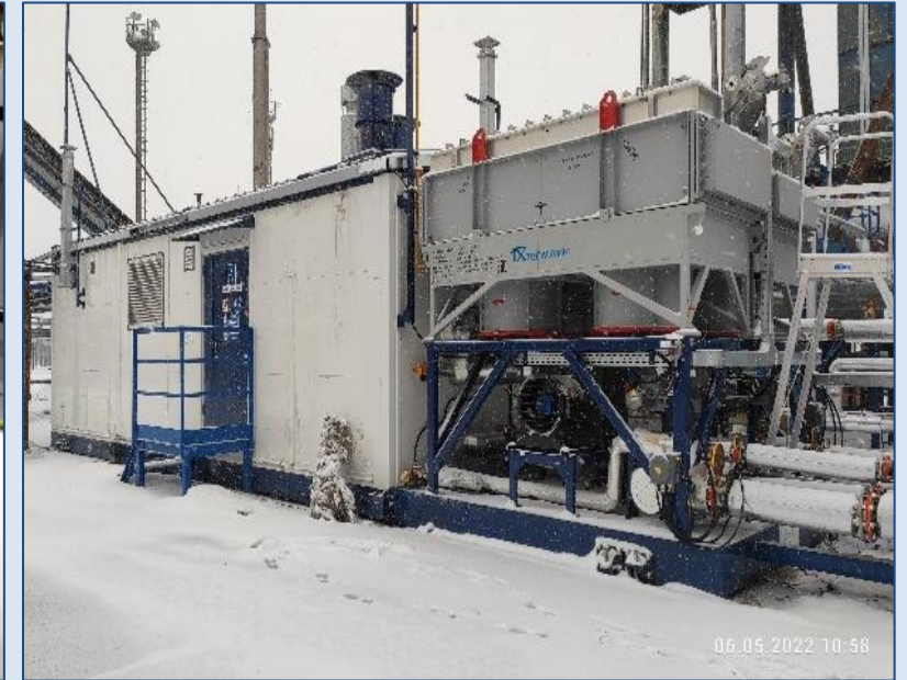
МКУ-001 на площадке ГПН-ННГ проходит ОПИ
