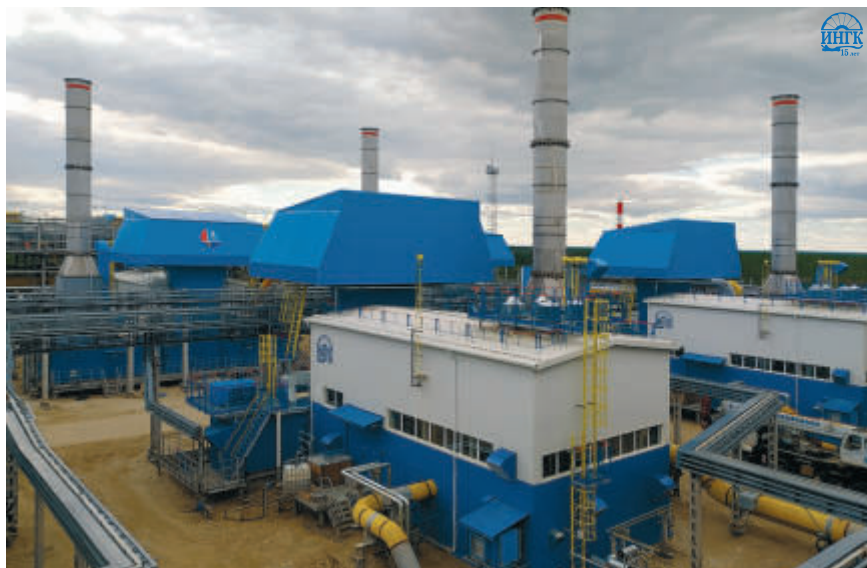
Рис. 2. ГПА-16 «Иртыш» в модульном исполнении на базе ГТУ и ЦБК отечественного производства
