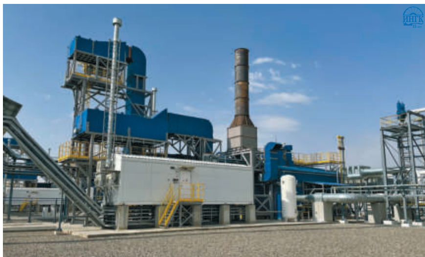
Рис. 5. ГПА-8 в Узбекистане на базе ГТУ и ЦБК зарубежного производства
